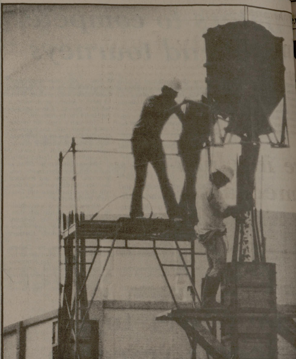
Pouring it on
