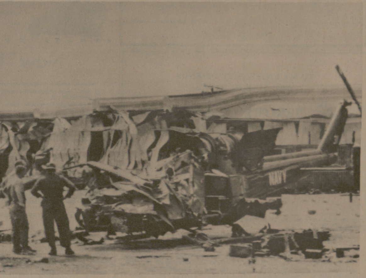
MORTAR DAMAGE TO U. S. BASE
